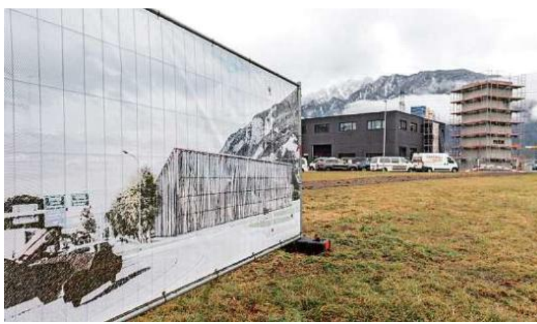
Im Sommer soll der erste Spatenstich erfolgen: Visualisierung des Inno-Qube am Standort auf dem Rossboden in Chur Süd. (FOTO YANIK BÜRKL)
